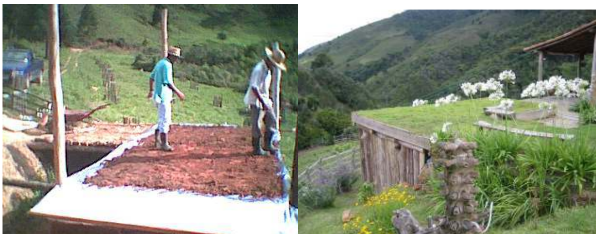
Fig 10 e11– Construção de telhado verde em Itamonte - MG Foto: Fernando Betim
