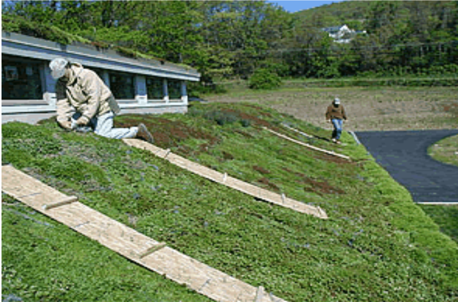
Fig. 6 – manutenção de cobertura vegetal. Fonte: ECOTELHADO (2007)
