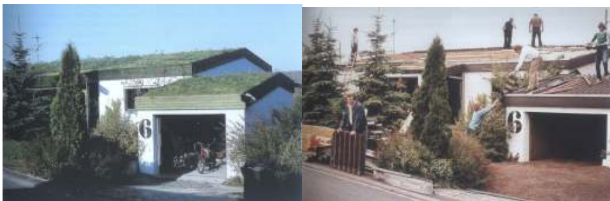
Fig.8e9 – Substituição de telhado por cobertura verde na Alemanha. Fonte: MINKE (2007)
