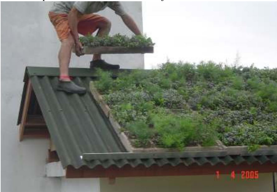
Fig. 5 - colocação de placas. Fonte: ECOTELHADO (2007)
