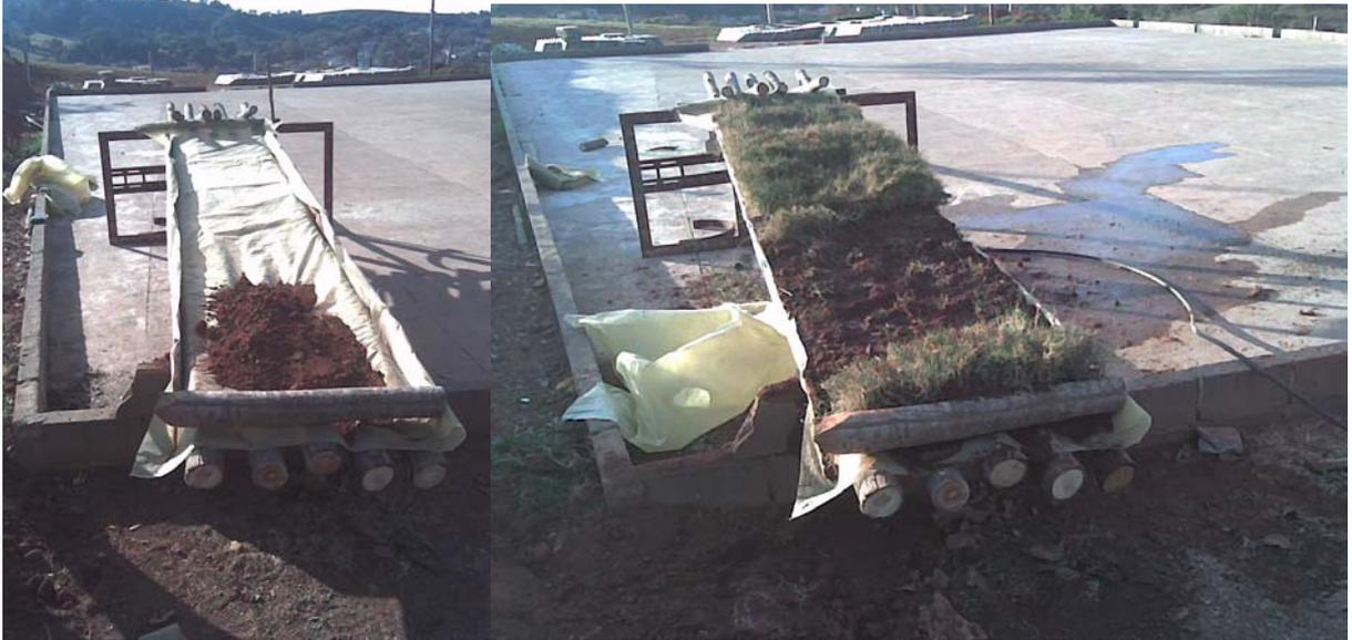
Fig. 8 e 9 – aplicação da camada de terra e da cobertura vegetal
