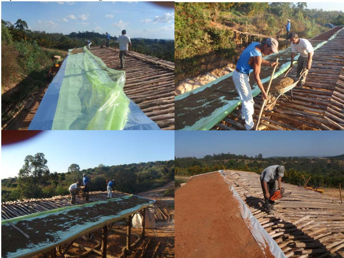
Fig. 11 a 14 – Colocação da camada de terra na cobertura do barracão
