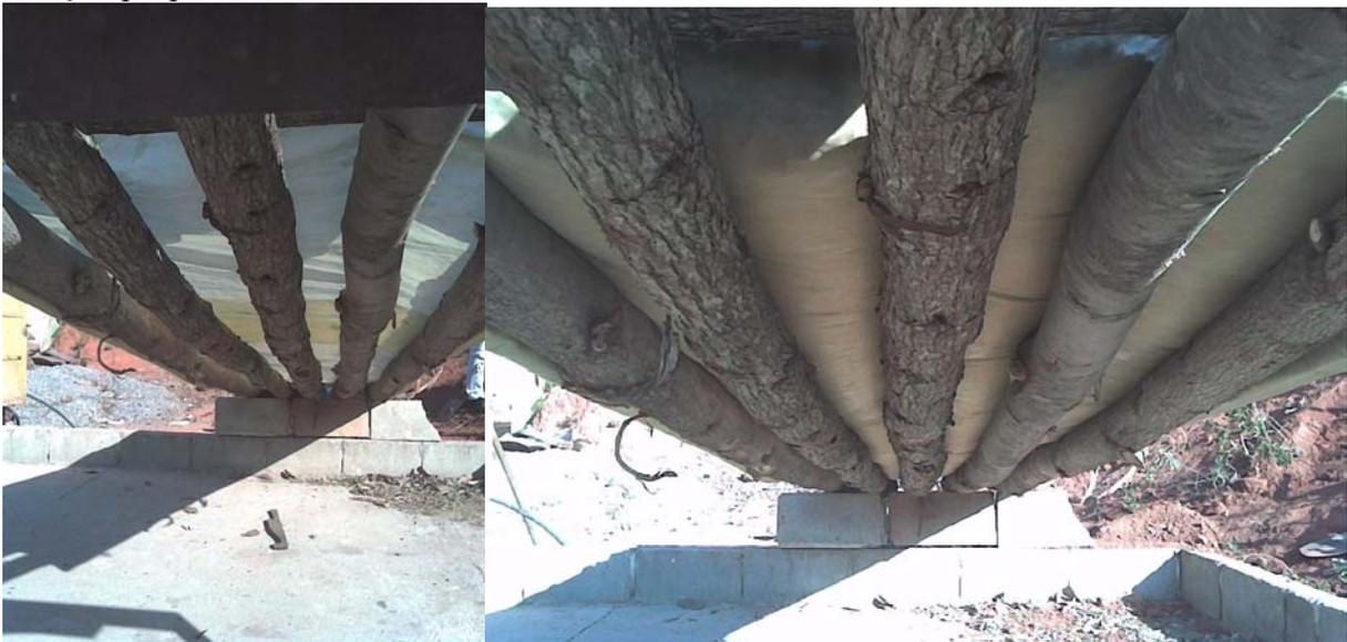
Fig. 6 e 7 – Vista inferior do filme plástico, antes e depois da colocação da camada de terra
