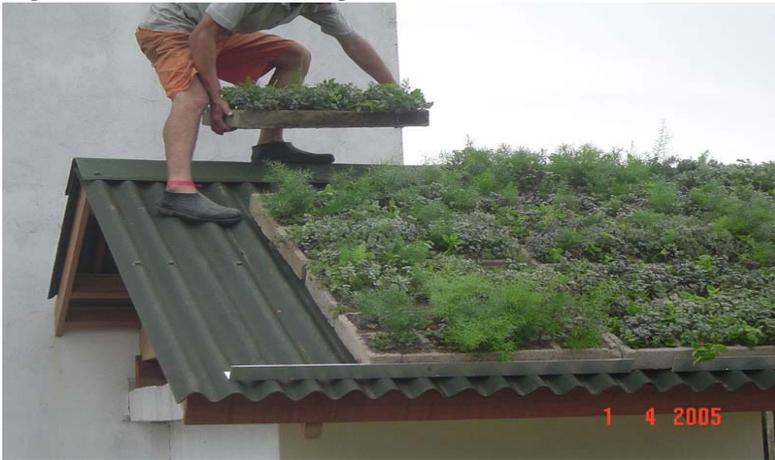
Fig. 2 - Colocação de módulos pré-elaborados. Fonte: ECOTELHADO (2007)
