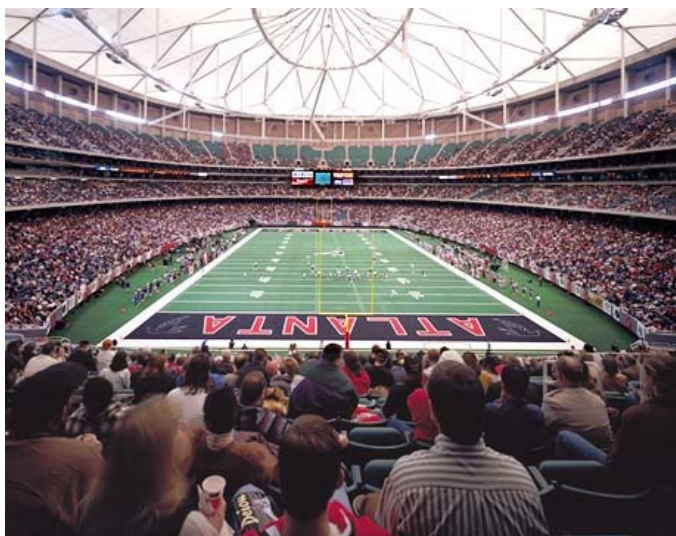
Fig. 7 – Geórgia Dome : Construído em 1992 para os Jogos Olímpicos de Atlanta 1996. Sua cobertura combina uma estrutura metálica tensegrity com painéis hiperbólicos de membranas. http://www.pbs.org/ (16/08/2007).
